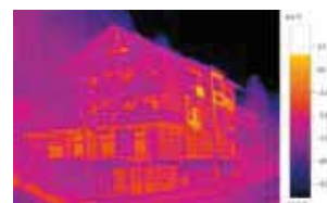
Imagen térmica con testo ScaleAssist
